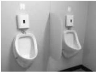
Os mictórios consomem geralmente 9 litros de água para cada 6 acionamentos da descarga para descarte de urina. As bacias sanitárias comuns, sem duplo acionamento gastam, em média, 36 litros para cada 6 acionamentos da descarga para descarte de urina.
